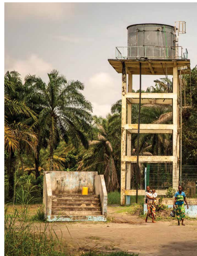
Fontaine d'eau potable de la base-vie d'Epéna (qui délivre plusieurs milliers de litres d'eau par jour) et château d'eau de Mokengui réparé en novembre 2024 (© WCS et © M. Nicolas)
